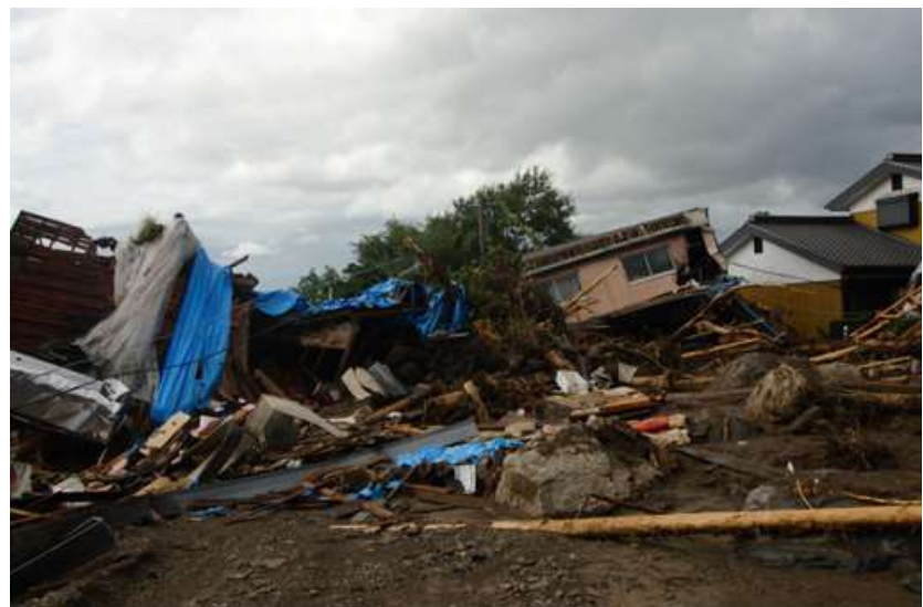
福岡県久留米市田主丸の土石流現場。土砂は一瞬にして住宅を損壊させる
